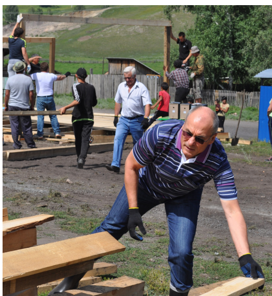
Строительство молодежной площадки а. Малый Монок
